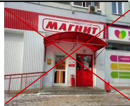
Отделка фасада профилированным металлическим листом
