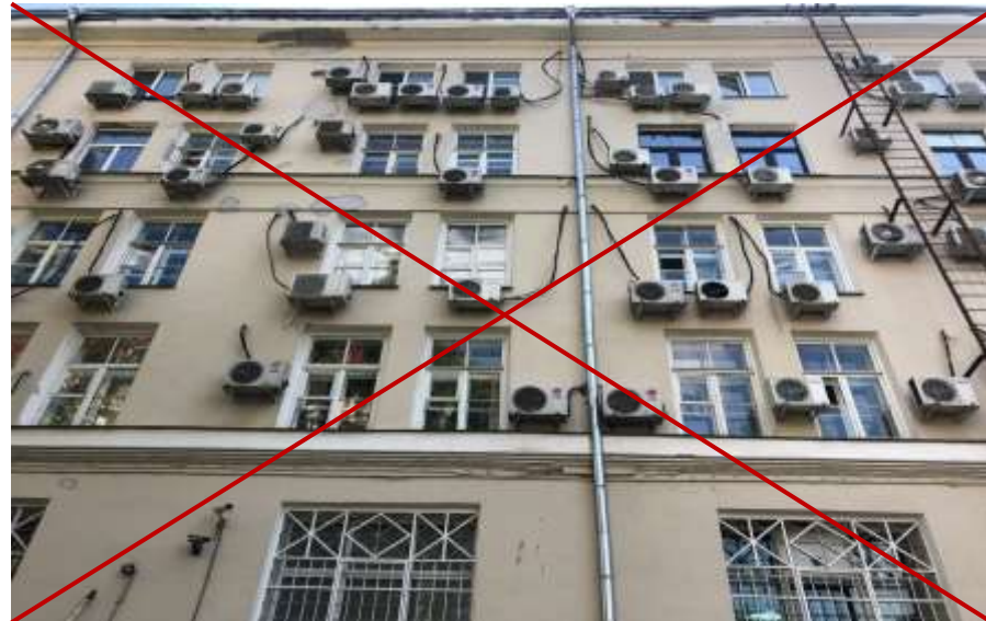
Пример неправильного размещения кондиционеров на внутрилвором фасаде
