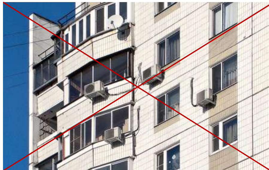
Пример неправильного размещения кондиционеров на внутрилвором фасаде
